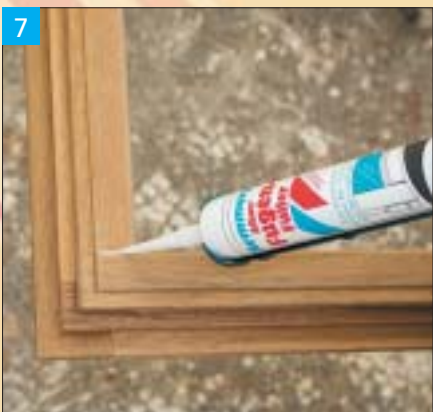
7 vyplnění spár pro ochranu před vlhkostí
